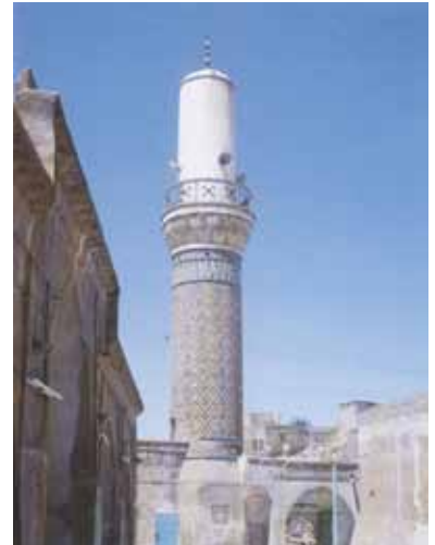
Nakışlı Minare Camii (H.1233) Yılında Yapılmıştır
